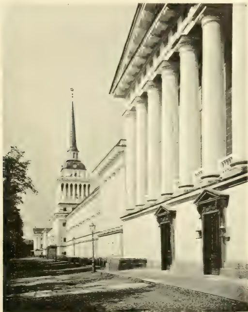
Façade principale et tour de l'Amirauté
